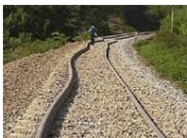
▲図1 高温で曲がった線路
